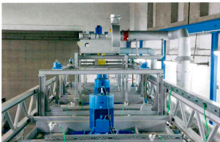
Abb. 7: Elektromotorische Verstellereinrichtung der Düsenkästen und Motoren der Umwälzventilatoren
